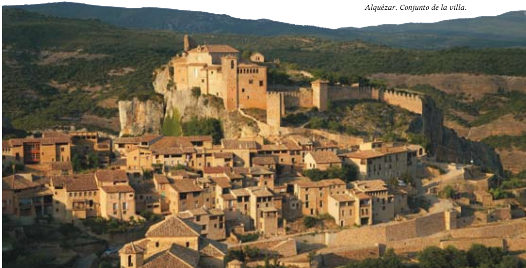
Alquézar. Conjunto de la villa.
